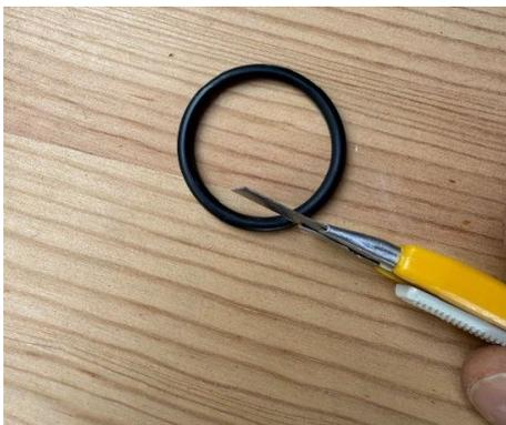
6 Der Dichtring der neuen Abdichtung wird mit einem Cutter 45 Grad Winkel aufgeschnitten um diesen um das Kabel legen zu können
